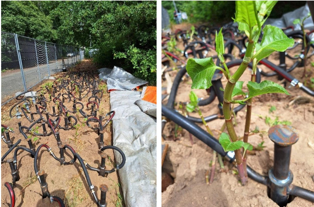
Figuur 6 Links: Overzicht pilot locatie met lansen en isolerende folie ernaast. Rechts: detail.
